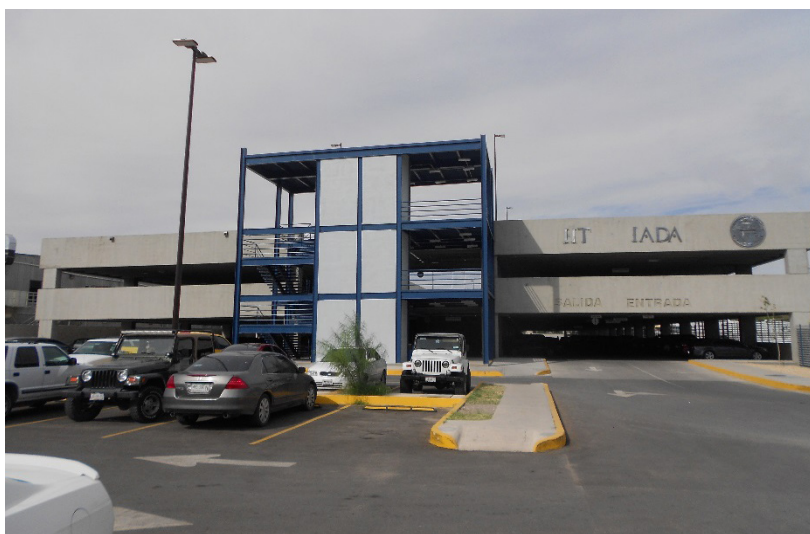
Fotografía 11.2. Estacionamiento del IADA-IIT
