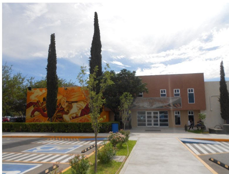
Fotografía 11.1. Edificio B del IADA
