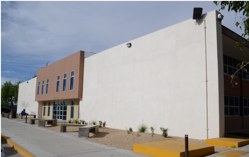
Fotografía 11.6. Edificio C del ICSA
