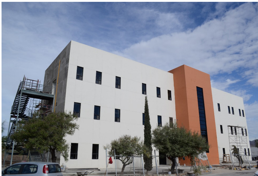
Fotografía 11.5. Edificio para Cubículos
